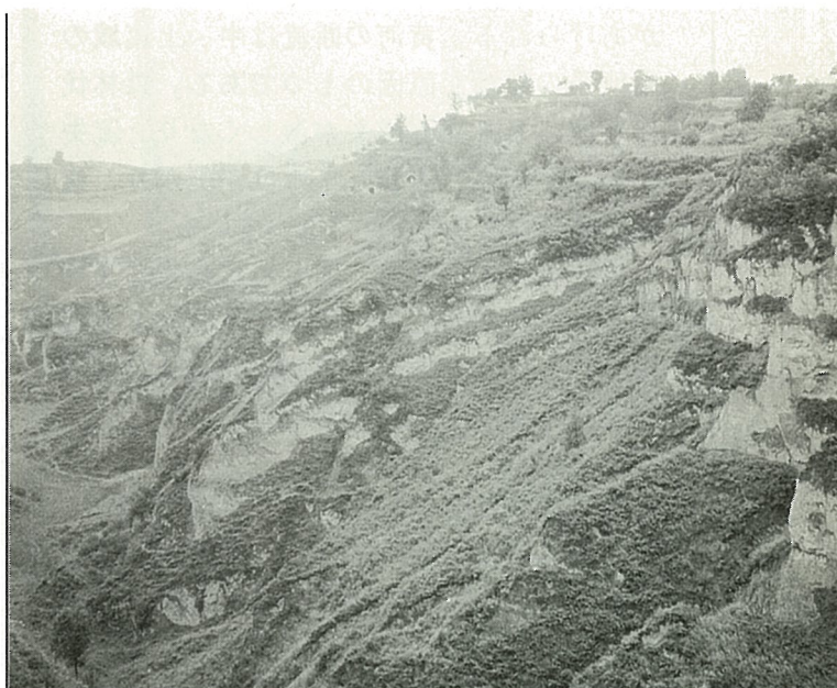
黄土高原のすさまじい表土流失。畑地の崩壊が広がる
