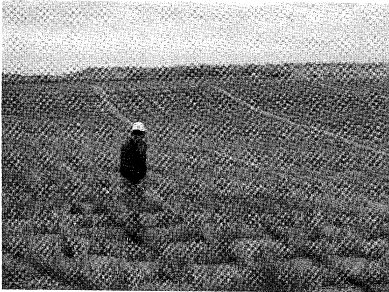
写真2 ヨシによる飛砂防止
