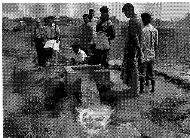
日本からの無償灌漑施設
