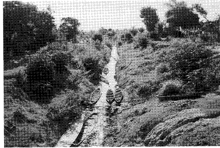
メコン川右岸のコルマタージュ水路（1997年5月下旬の状況）木橋から内陸部を望む。水路延長は約1km、メコン河の水位は水路底より約1m低い。内陸部では水稲、トウモロコシ、トウガラシ等が水路沿いに栽培され、水路末端では減水期稲の栽培が行われている。
