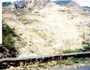
1990年バギオ地震(M7.8)による山腹崩壊
