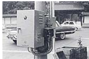
東京九段三丁目交差点に設置された交通管理システム 1964年
