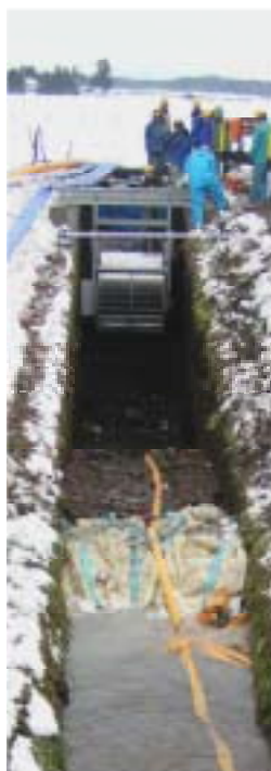
排水ポンプによる水路のバイパス
