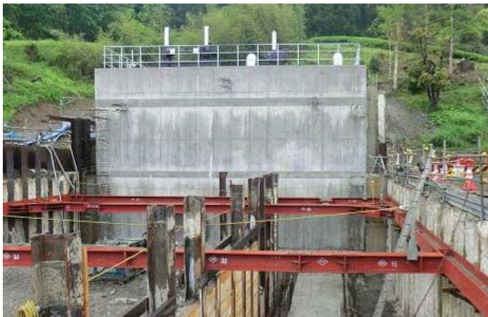
建設中の伊太発電所 (ヘッドタンク)
