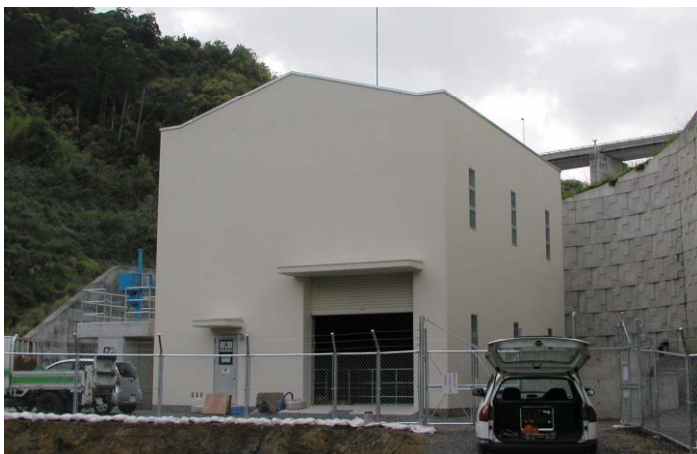
輝北ダム発電所外観
