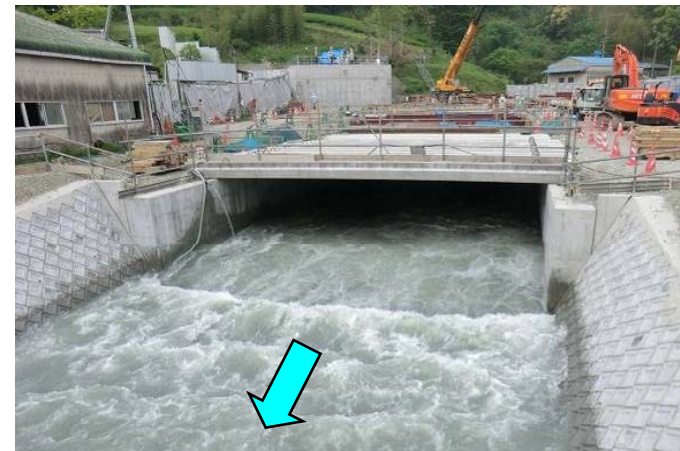
建設中の伊太発電所 (放水路)
