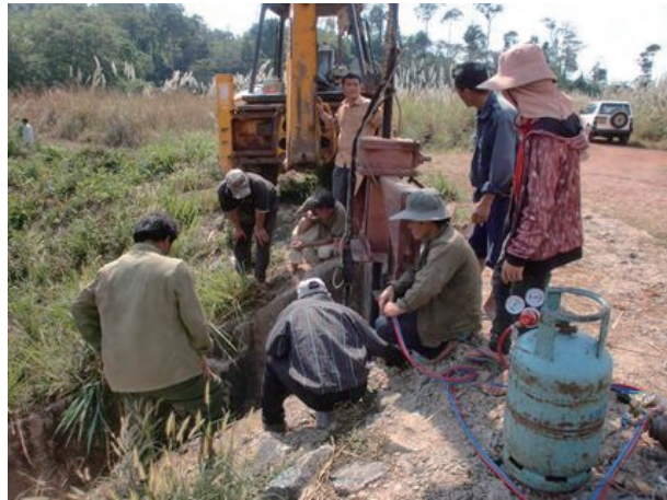
写真 44 取水口ゲート補修工事中(1)
