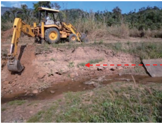
写真 35 水路コンクリート壁補修工事
