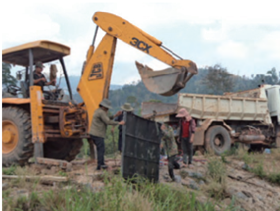
写真 45 取水口ゲート補修工事中(2)
