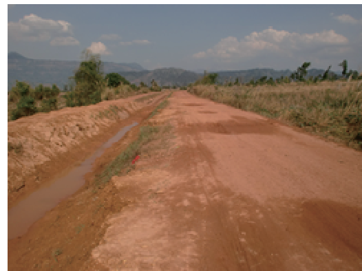
写真 40 管理用道路の補修完工
