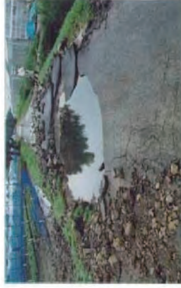
管の破損に伴う漏水により道路が陥没
