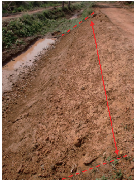
写真 33 幹線水路堤補修の完工(1)
