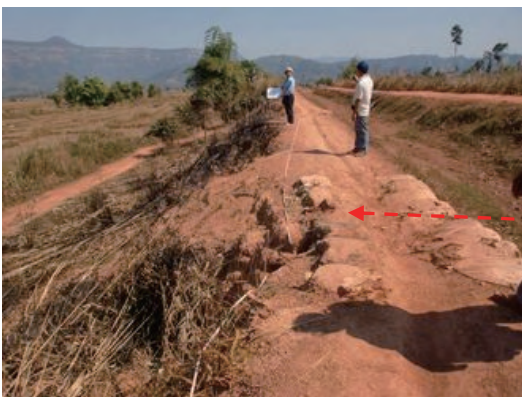
写真 41 崩壊箇所の事前調査
