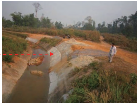
写真 36 補修工事の完工
