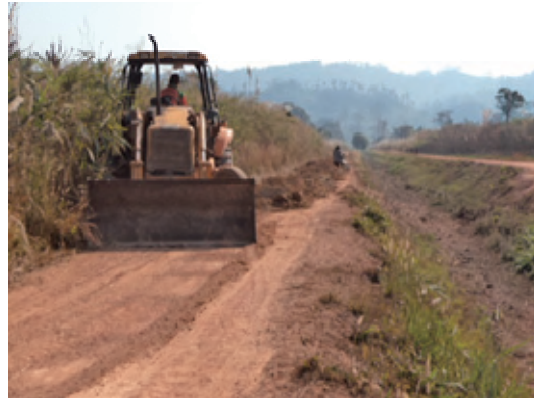
写真 38 管理用道路の施工状況
