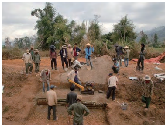
写真 32 幹線水路堤の補修工事(2)
