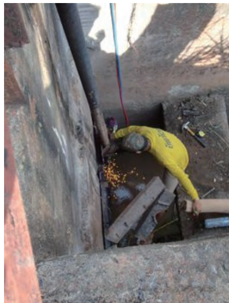
写真 46 取水口ゲート補修工事中(3)
