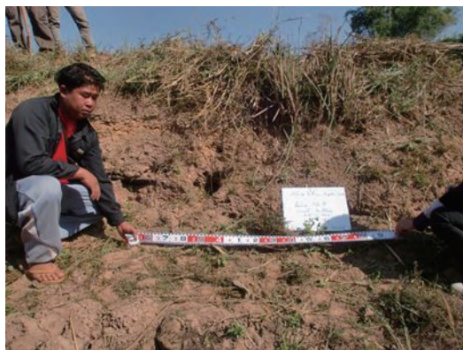
写真 30 幹線水路堤の穴の調査
