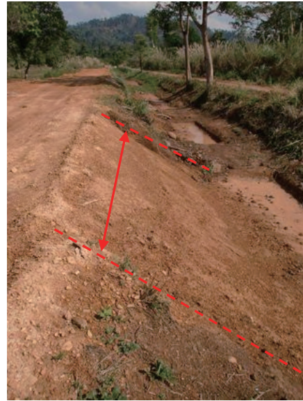
写真 34 幹線水路堤補修の完工(2)
