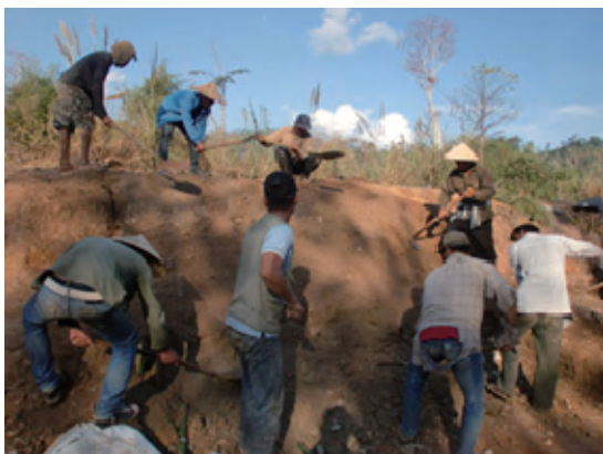
写真 31 幹線水路堤の補修工事(1)
