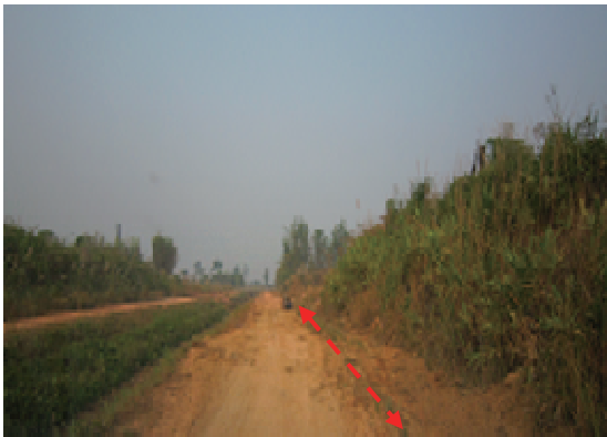
写真 39 側溝の掘削完工
