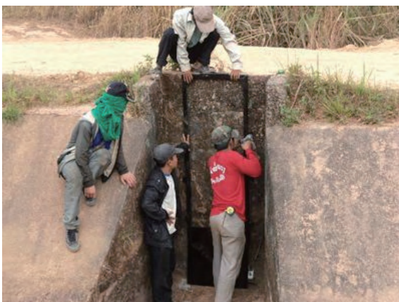
写真 51 農民によるゲートの据え付け
