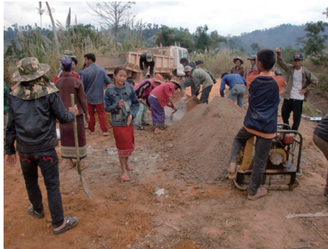
写真 27 ソイルセメントの製造
