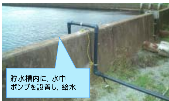
吉田浜送水機場貯水槽
