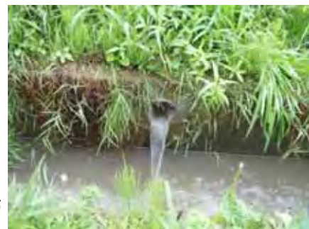
暗渠からの排水
