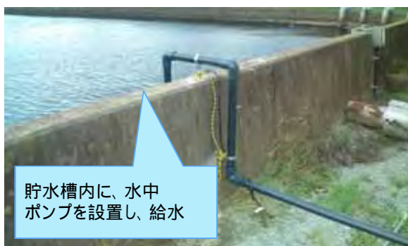
吉田浜送水機場貯水槽
