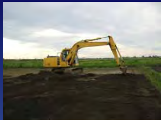
【掘削機械】 バックホウ0.45m3級 【アタッチメント】 法面バケッタタイプ
