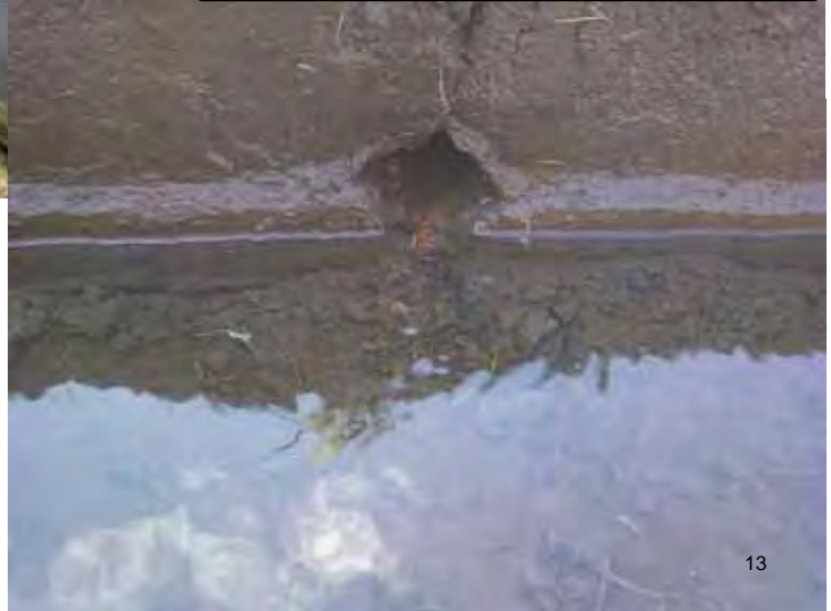
落水状況（弾丸暗渠からの排水）
