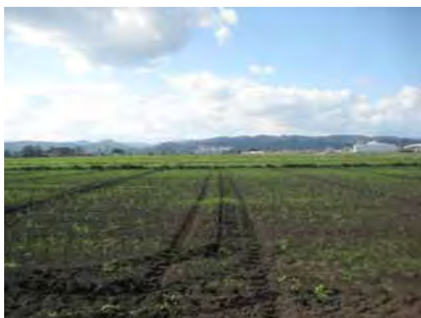
弾丸暗渠の施工(11/8) この後耕起
