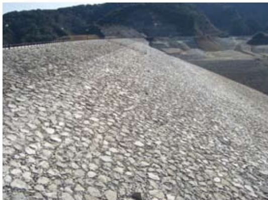
木之川内ダム (2009年完成) (ロックフィルダム：宮崎県)
