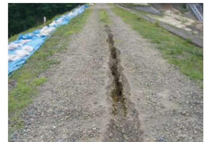
東北地方太平洋沖地震で被災した西郷ダム (アースダム：福島県)
