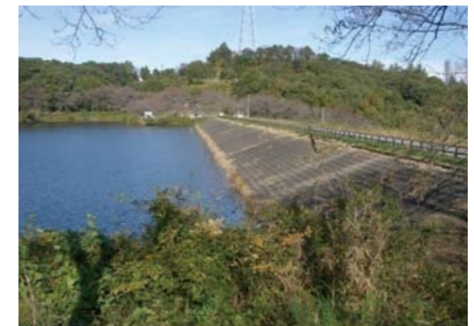
供用開始から47年が経過した竹沼貯水池 (アースダム：群馬県)
