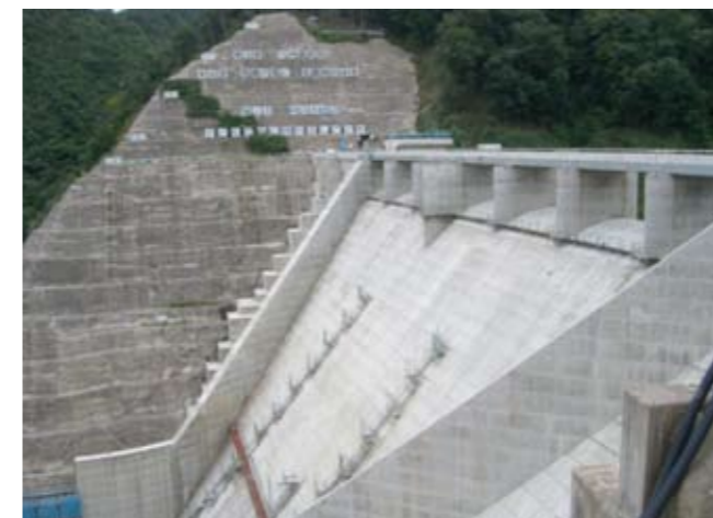
建設中の浜ノ瀬ダム (コンクリートダム：宮崎県)
